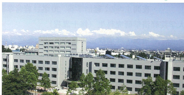
2004年耐震改修後の校舎
