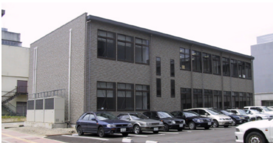
駐車場側から見た多目的ホール
