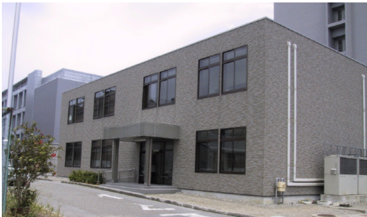
多目的ホール 1号館南側
