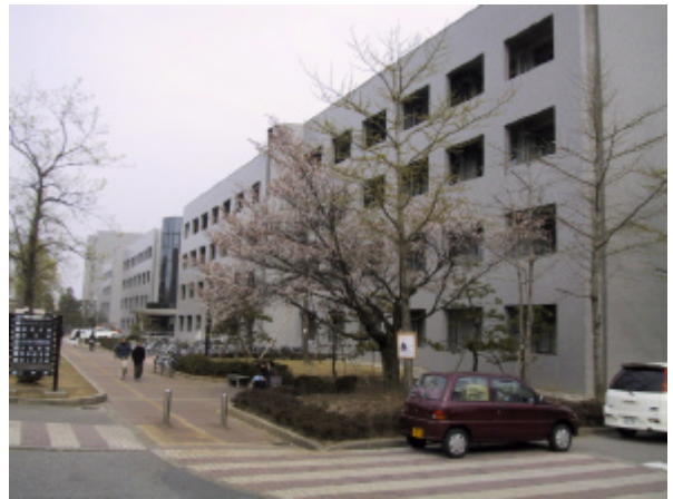
(右) 2号館側からみた校舎
