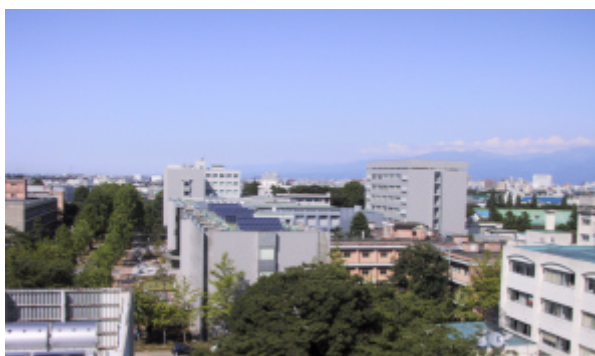
附属図書館から観た太陽光発電モジュール
