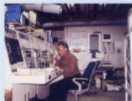
昭和基地管理棟の通信室
