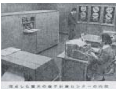
「北日本新聞掲載」より：第1世代コンピューターOKITAC 5090-C システムと電子計算室
