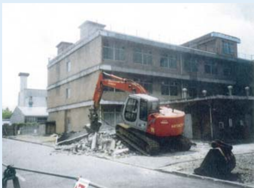
『第4期改修工事始まる』
