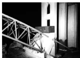
橋脚、および橋台の設置
