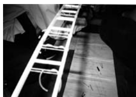
アーチリブの製作
